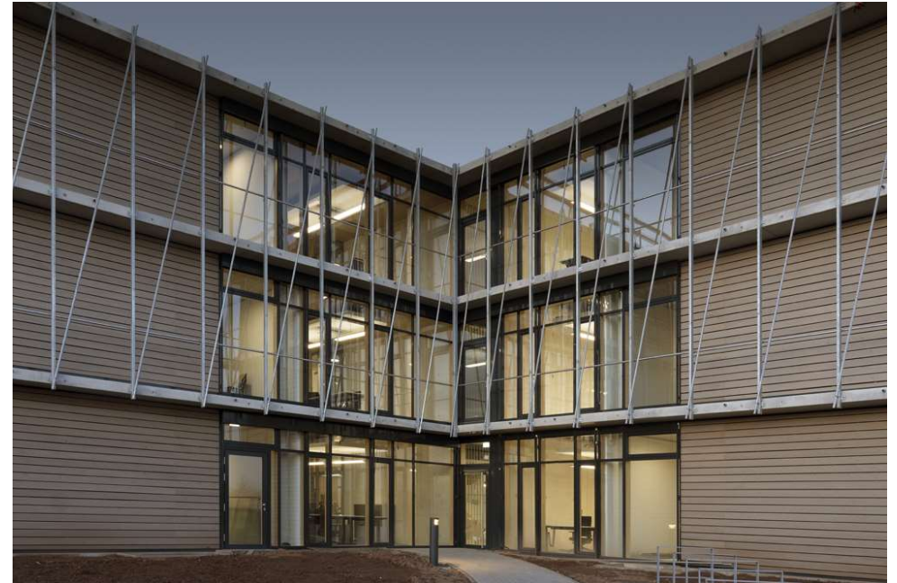
Neubau Kreishaus Korbach
